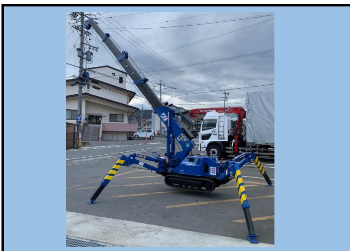
2.35t吊り カニクレーン
